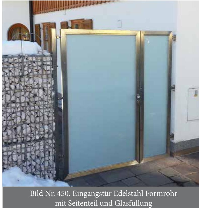
Bild Nr. 450. Eingangstür Edelstahl Formrohr mit Seitenteil und Glasfüllung
