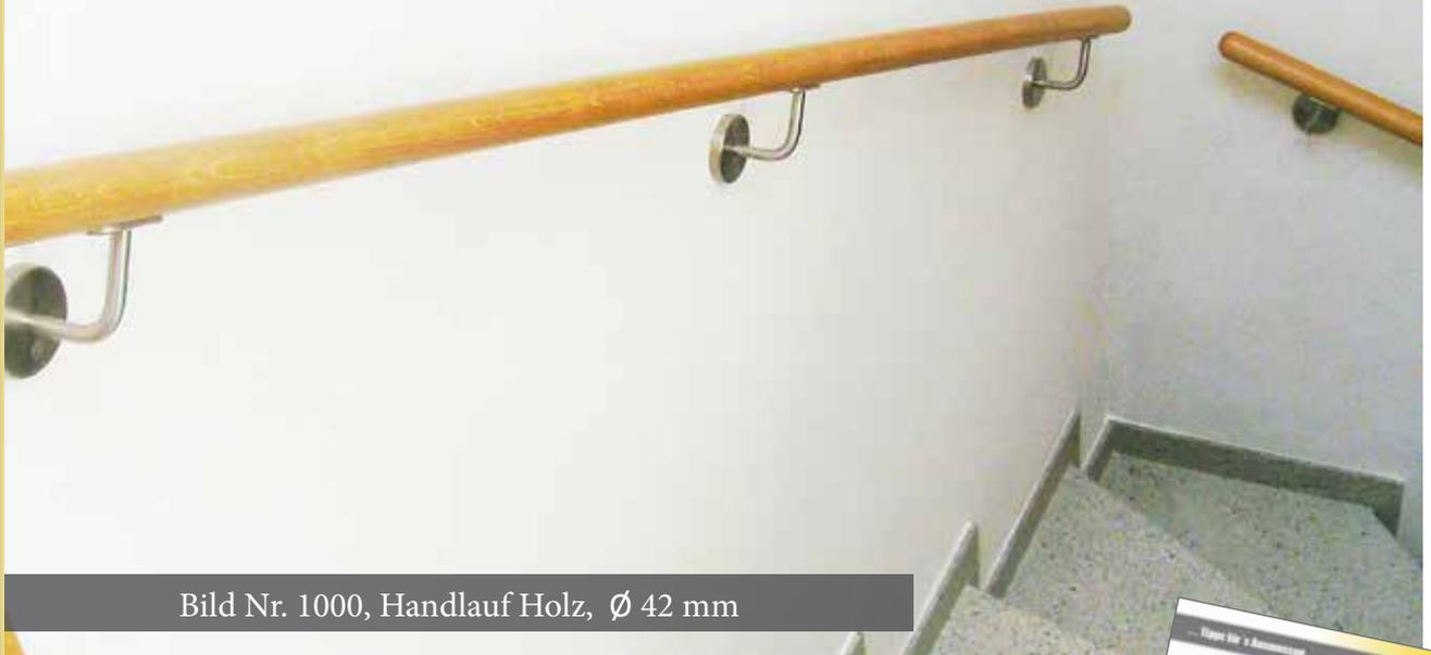
Bild Nr. 1000, Handlauf Holz,  $\varnothing$  42 mm
