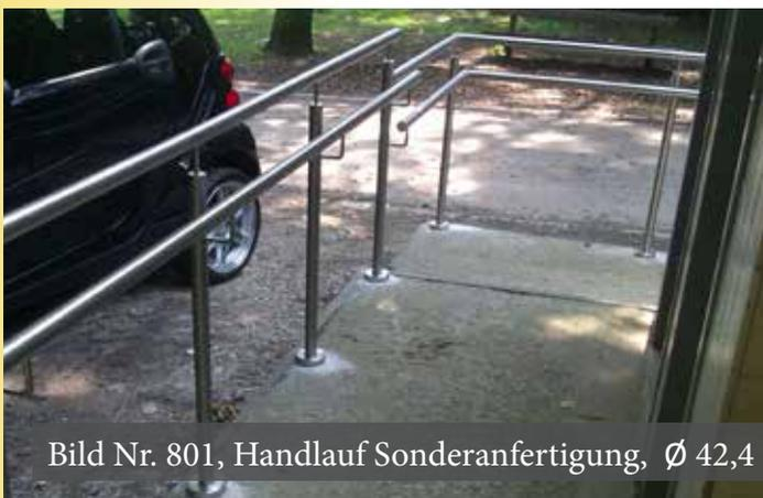
Bild Nr. 801, Handlauf Sonderanfertigung, Ø 42,4
