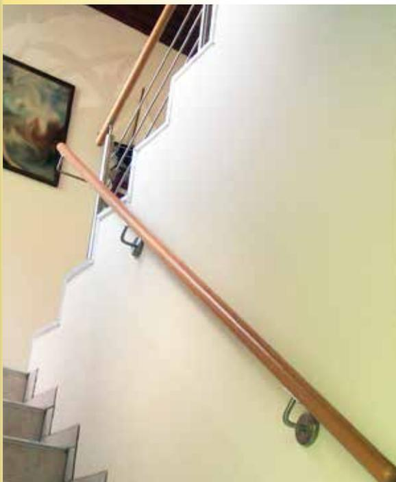
Bild Nr. 1055, Handlauf Holz,  $\varnothing$  42 mm
