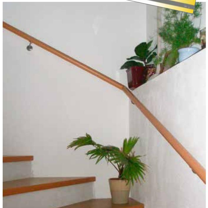
Bild Nr. 1020, Handlauf Holz,  $\varnothing$  42 mm
