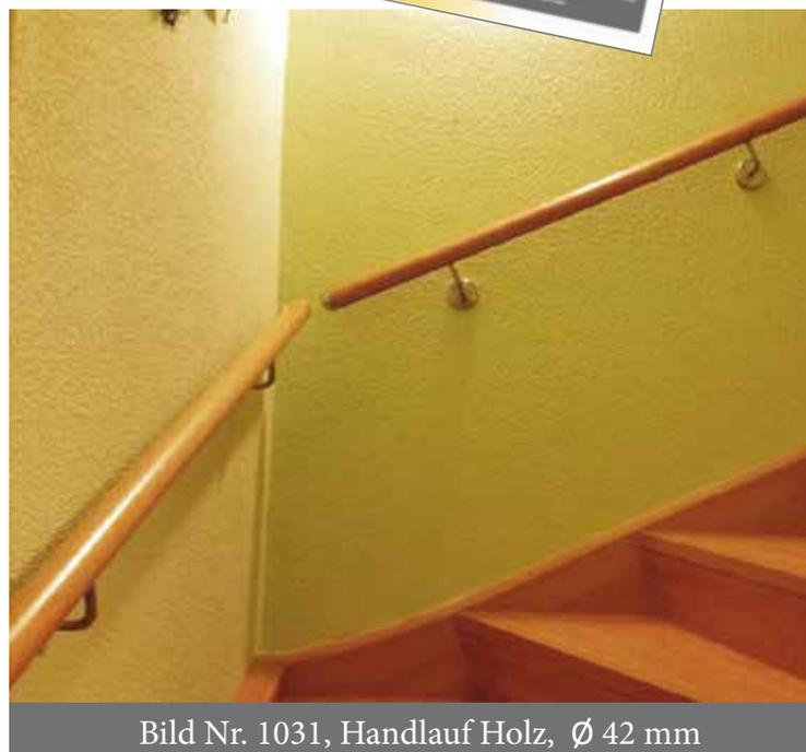
Bild Nr. 1031, Handlauf Holz, Ø 42 mm
